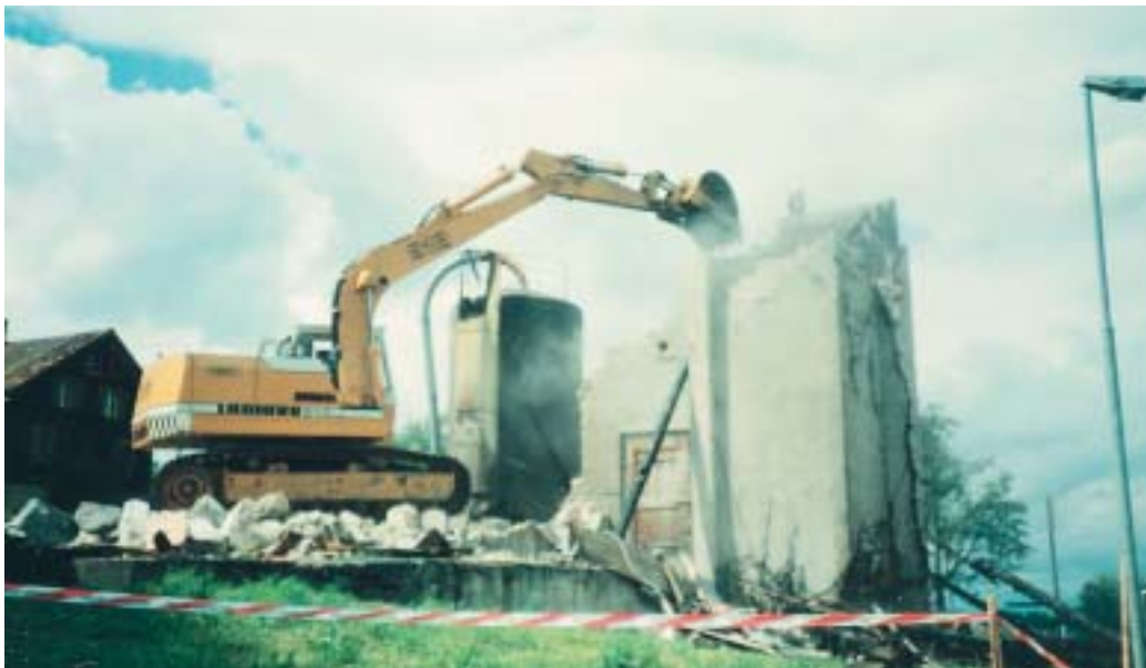
Abbruch des Brandobjekts Boog, im Sommer 1985, mit eingemietetem «gelbem» Bagger.
